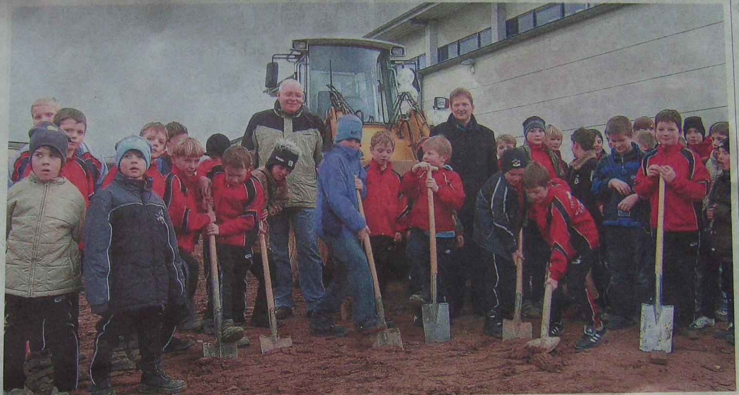
Rathauschef Torsten Kunkel und TSV-Vorsitzender Dietmar Binder überließen den Kindern den Spatenstich für den neuen Sportplatz.
