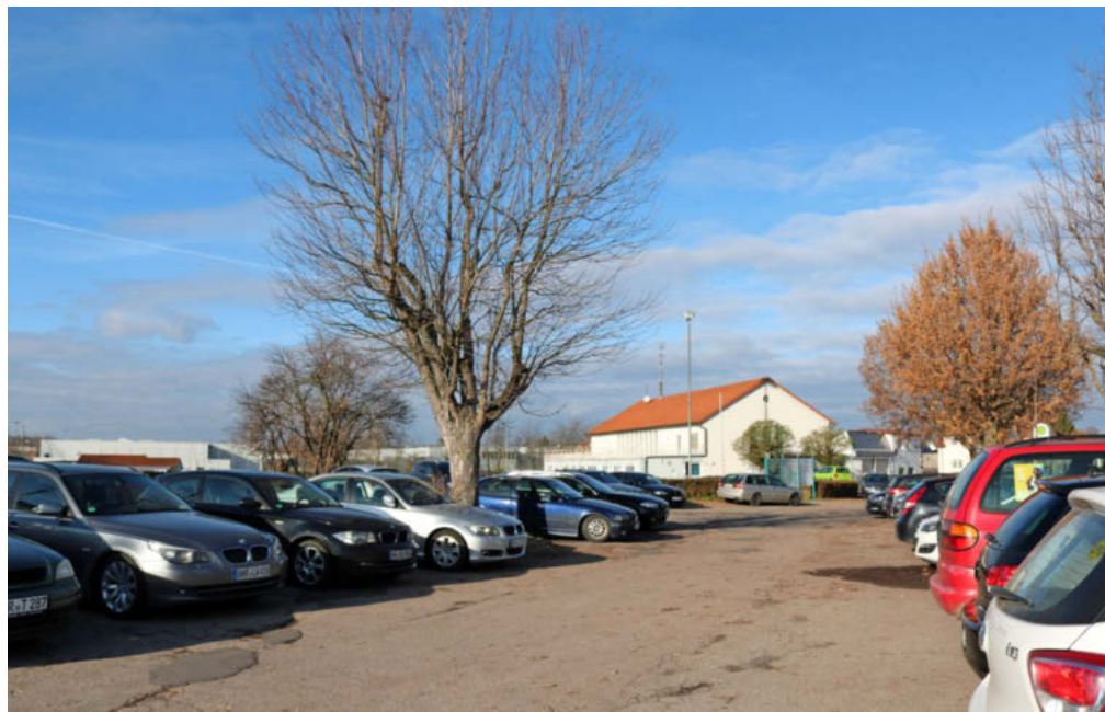
In schlechtem Zustand ist der Asphalt des Parkplatzes bei der alten Erich-Fritz-Halle. Wenn diese abgerissen ist, soll auch der Parkplatz neu gestaltet werden.
